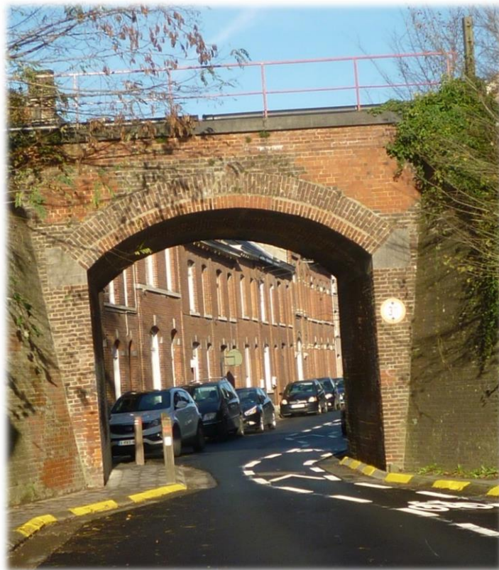
Figure 11 : Rue des Ponts : porte de l'hypercentre. Sens unique limité avec prédominance des modes doux sur la circulation motorisée
