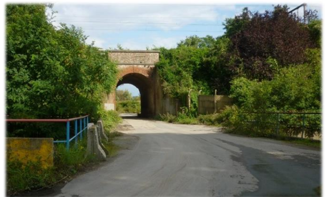
2. Passage sous le chemin de fer
